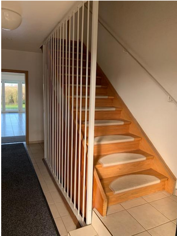
Solide Holztreppe zum OG
