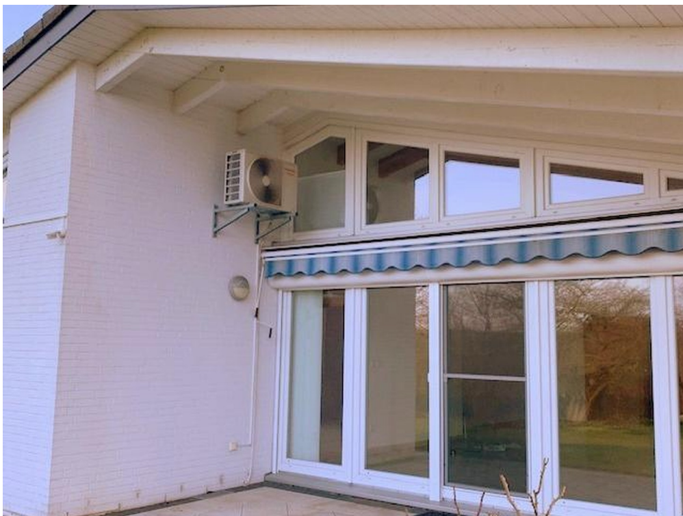
Terrasse mit Außenmarkise
