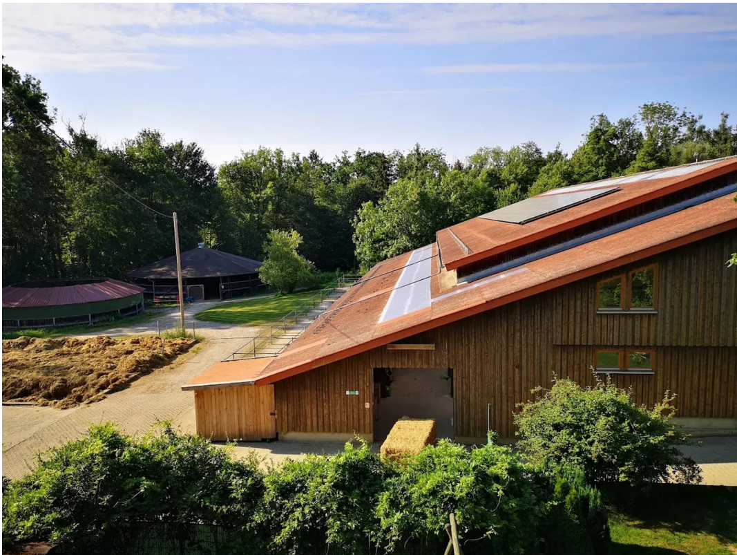
Hallenstall mit PV-Anlage
