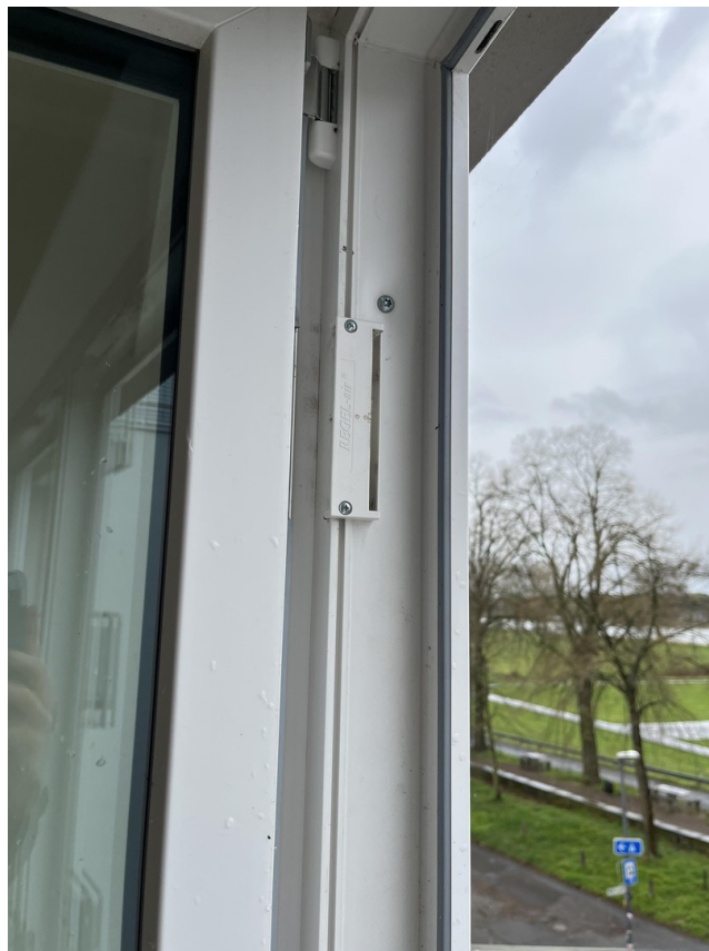
Neue Fenster mit Lüfter
