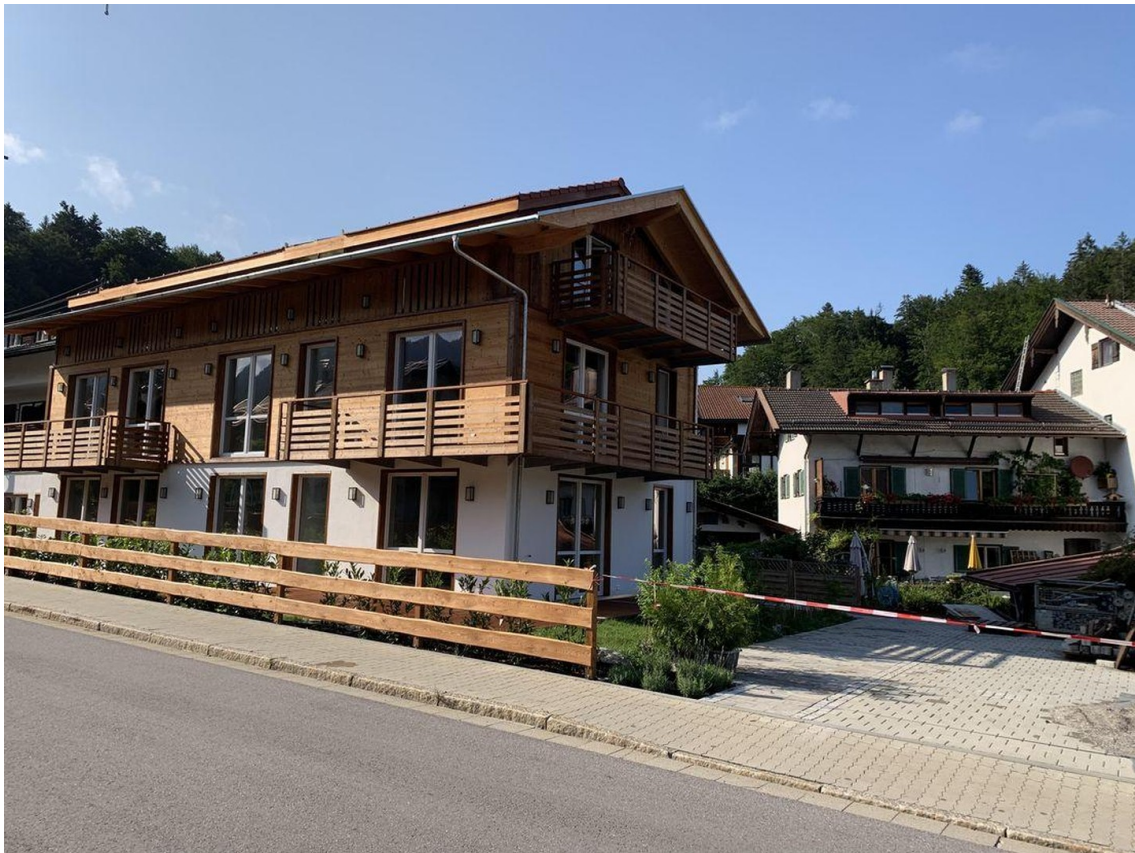
Ansicht von Süd / Osten
