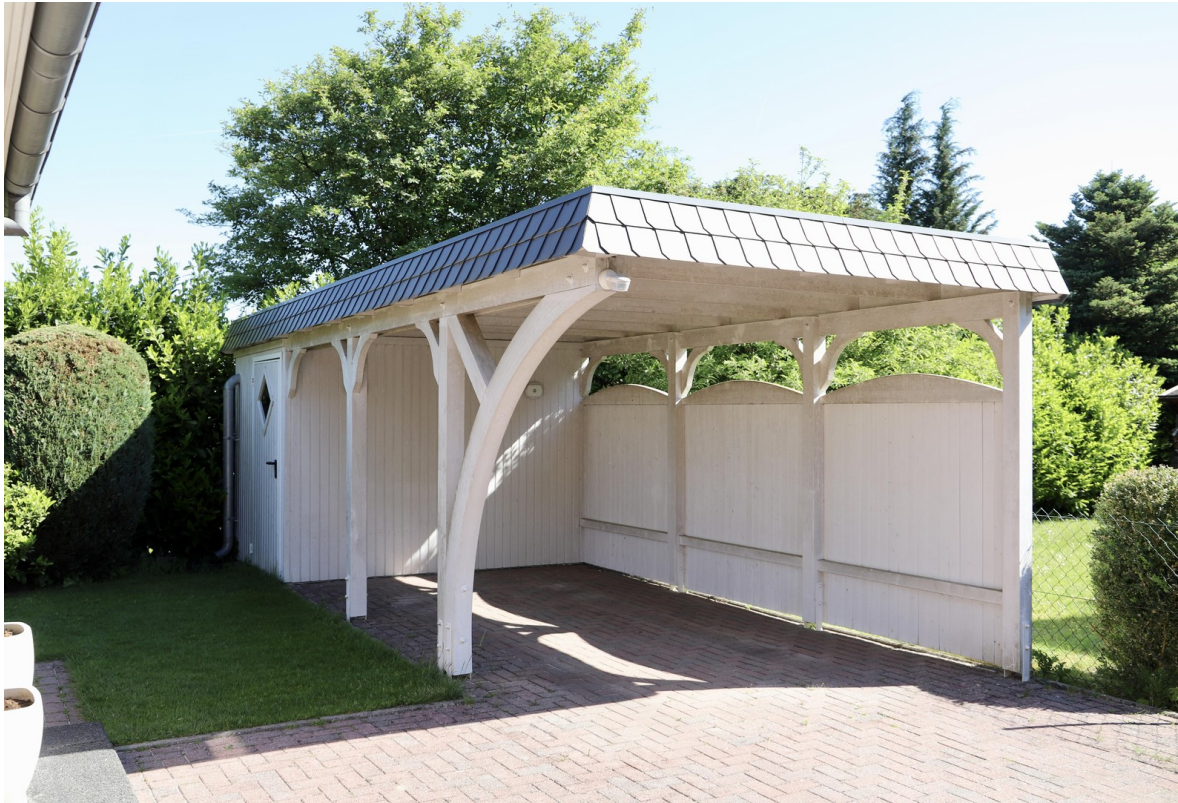
Carport mit Abstellraum
