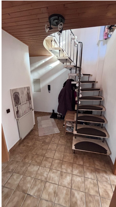
Flur, Boden kommt neu
