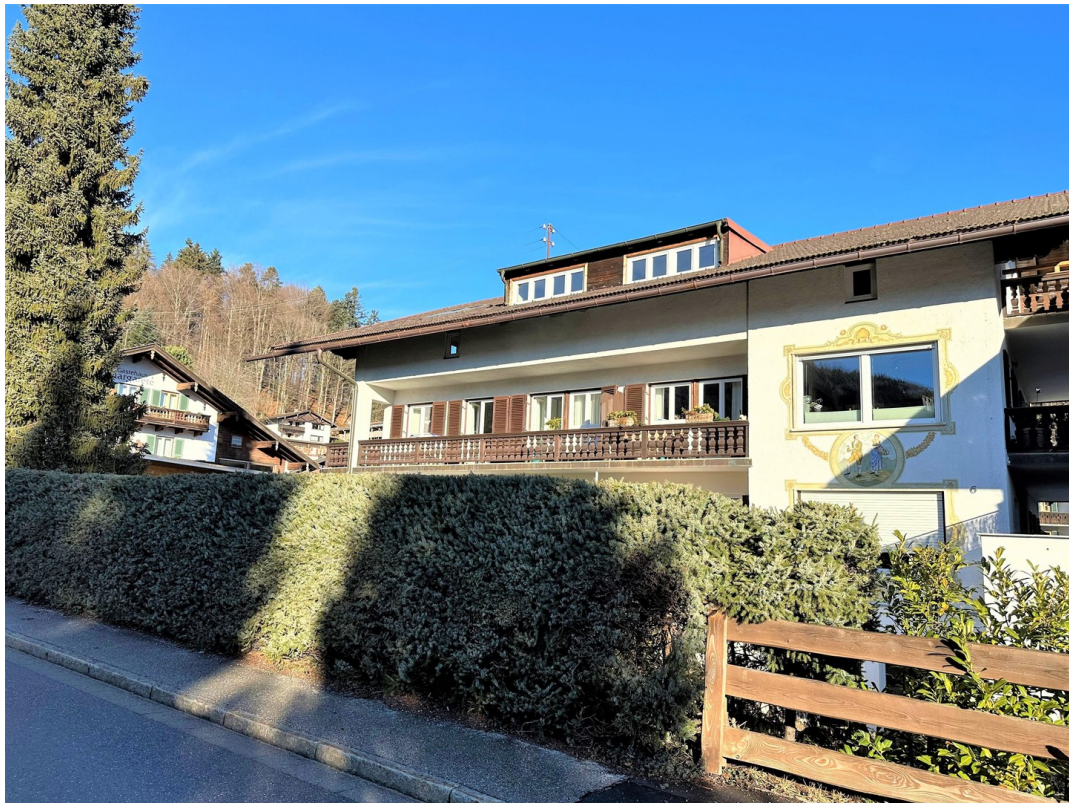
Ansicht vom Süden
