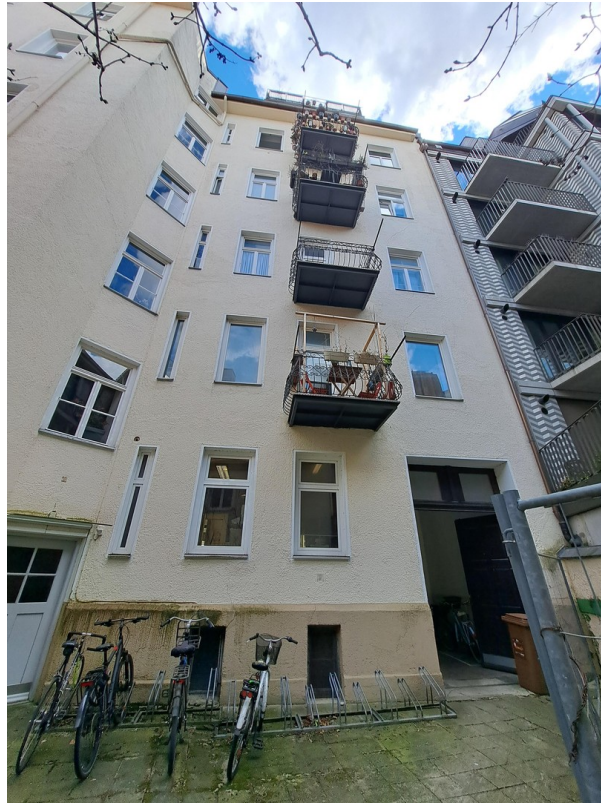
Fassade zum Hof
