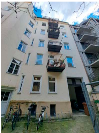
Fassade Erhardtstr. 11 zum Hof 1
