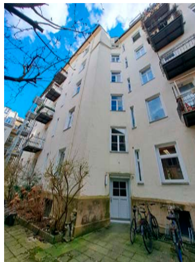
Fassade Erhardtstr. 11 zum Hof 2
