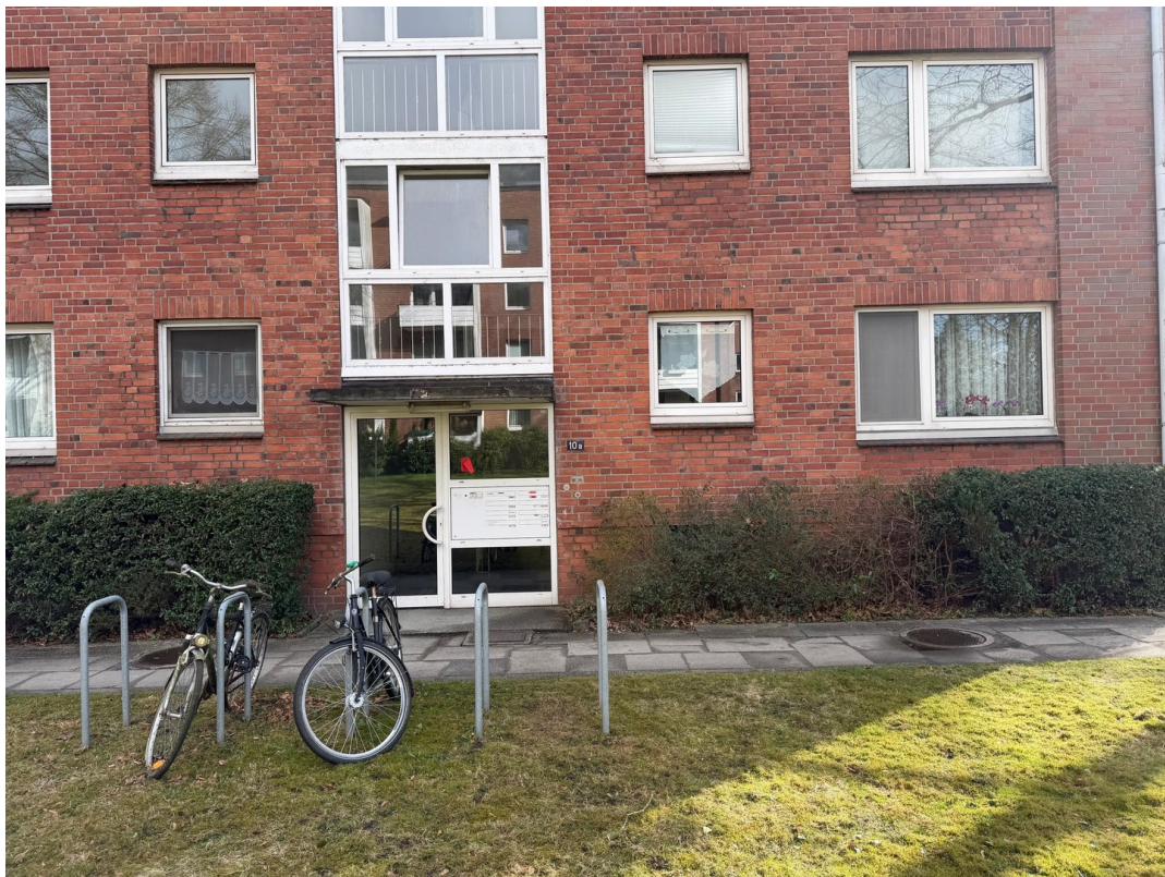
Haus außen (vorne)
