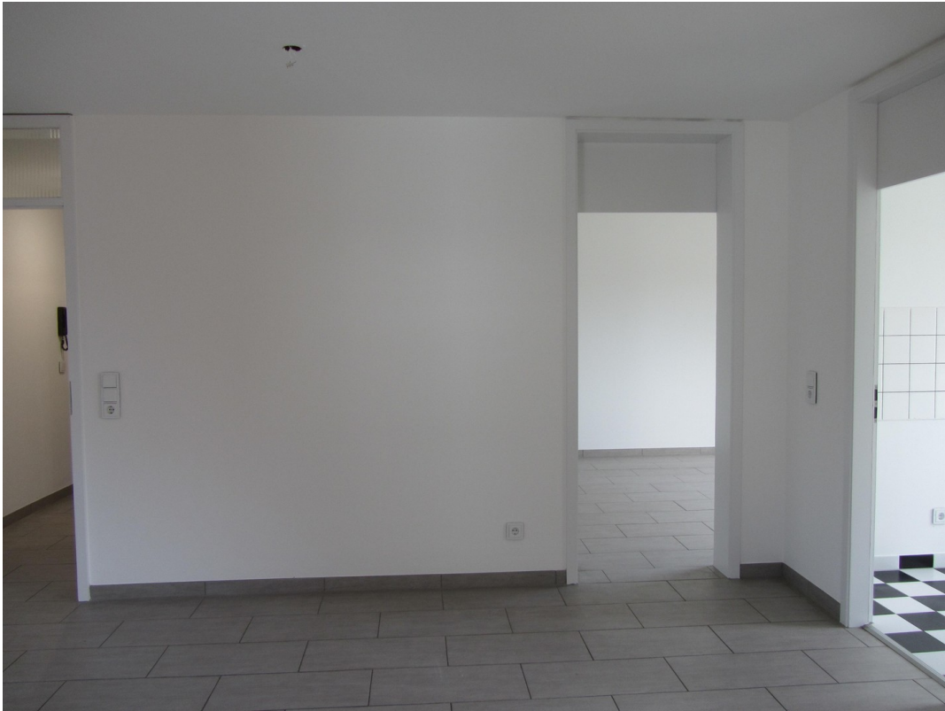
während der Renovierung
