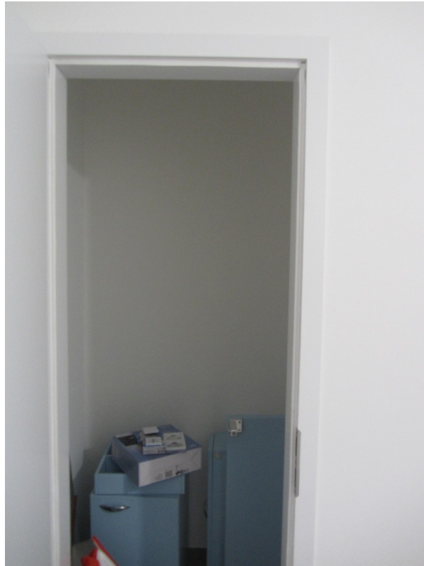
AB Flur während Renovierung
