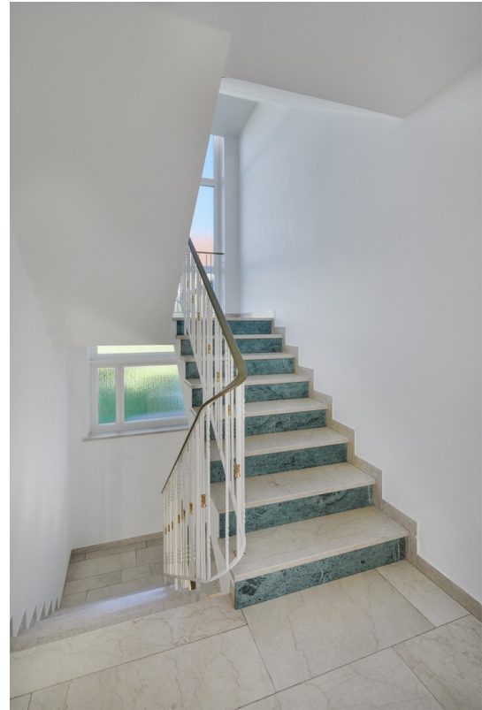
Treppe mit Natursteinbelag
