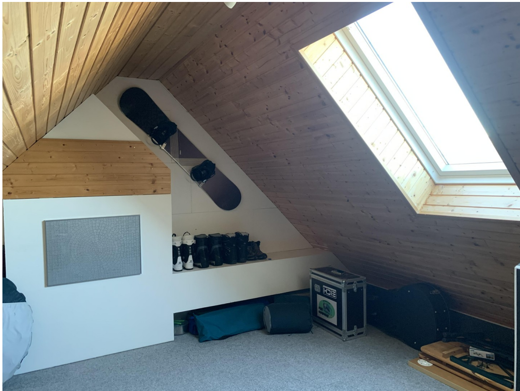
Gedämmter Spitzboden Gegens.
