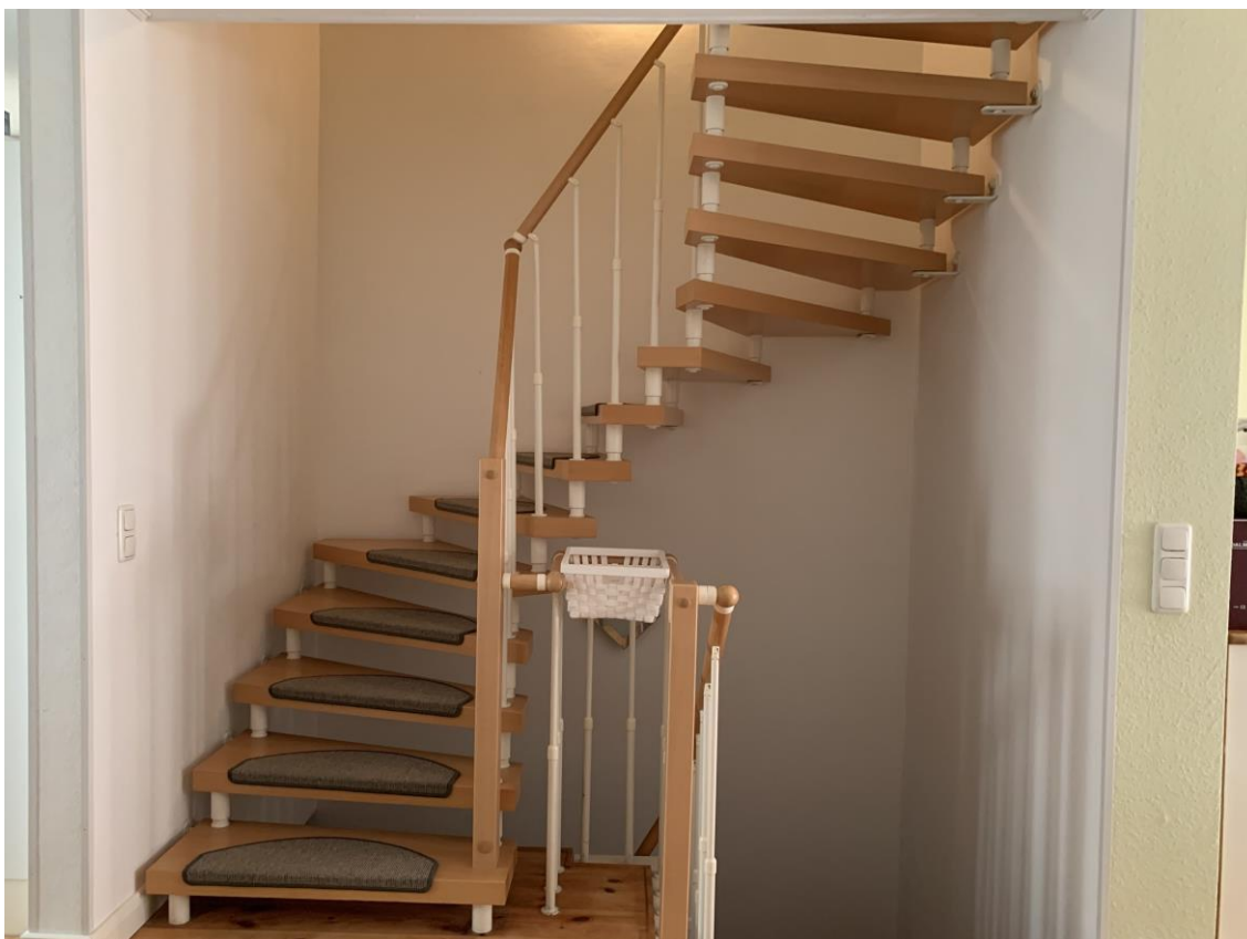
Offene Holzterre zum Obergeschoss
