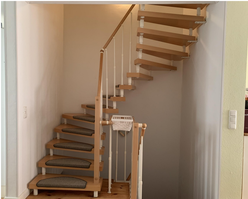
Offene Holztreppe zum OG
