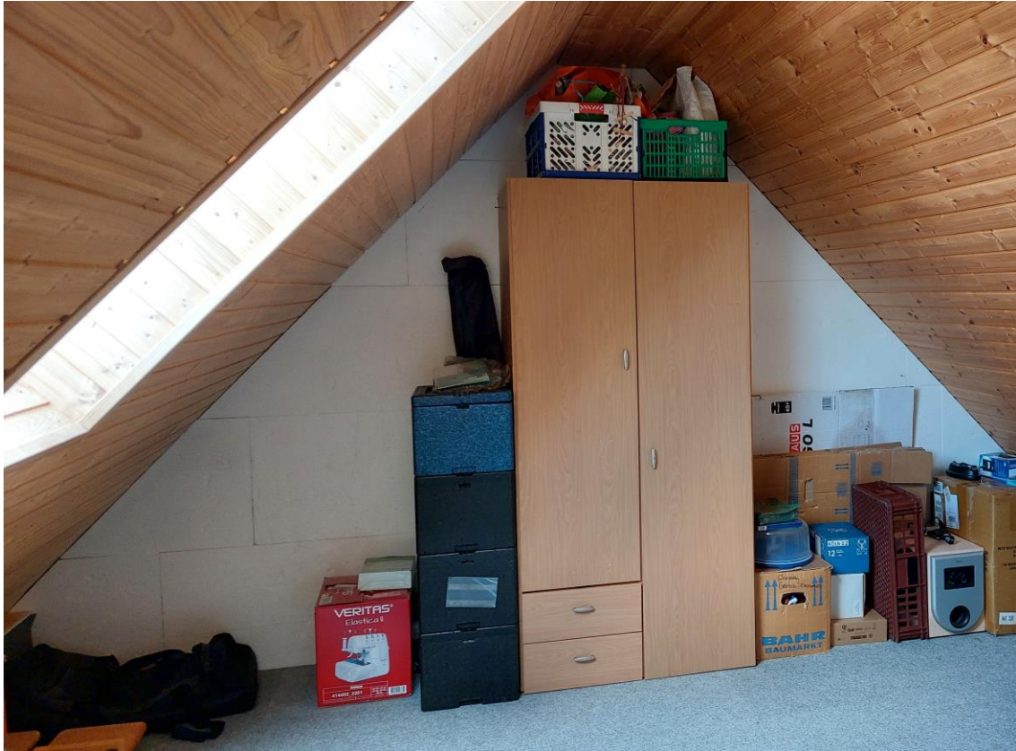
Gedämmter und ausgebauter Spitzboden
