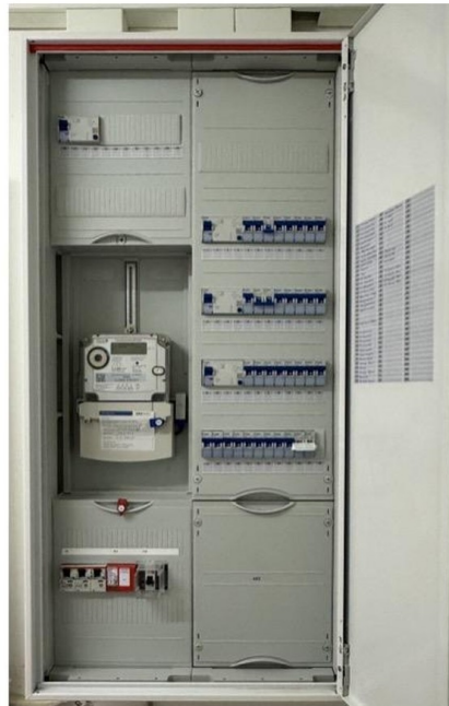
Der Sicherungskasten, 2024 erneuert :
