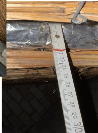
Das Dach ist von oben bis unten gedämmt. Hier ein Blick durch eine Revisionsür (18cm Mineralwolle):
