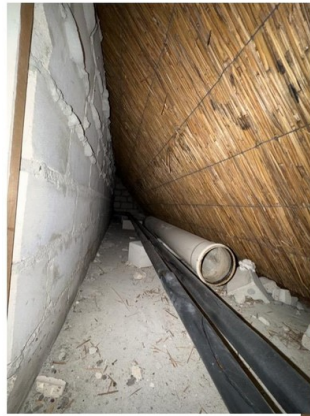
Das Dach ist von oben bis unten gedämmt. Hier ein Blick durch eine Revisionsür (18cm Mineralwolle):
