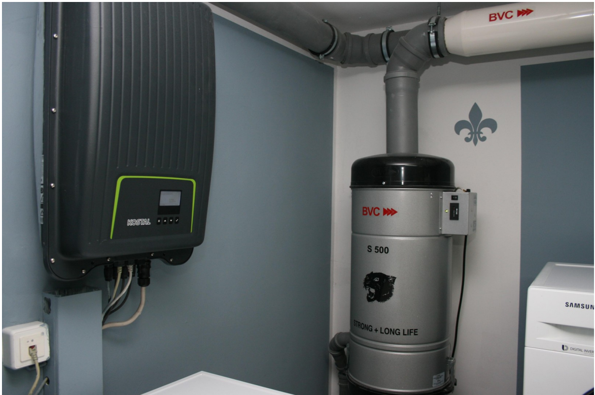
Zentralstaubsaugeranlage
