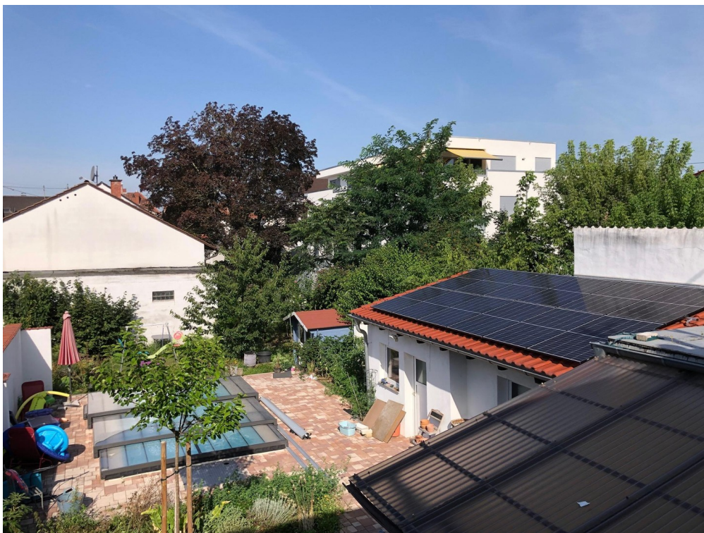
Pool und PV Anlage
