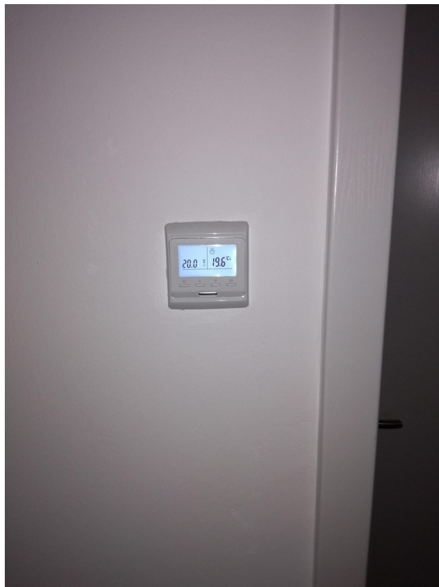
Steuerung Fussbodenheizung
