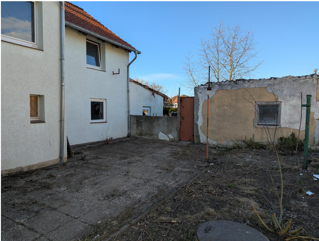
Haus seitlicher Weg
