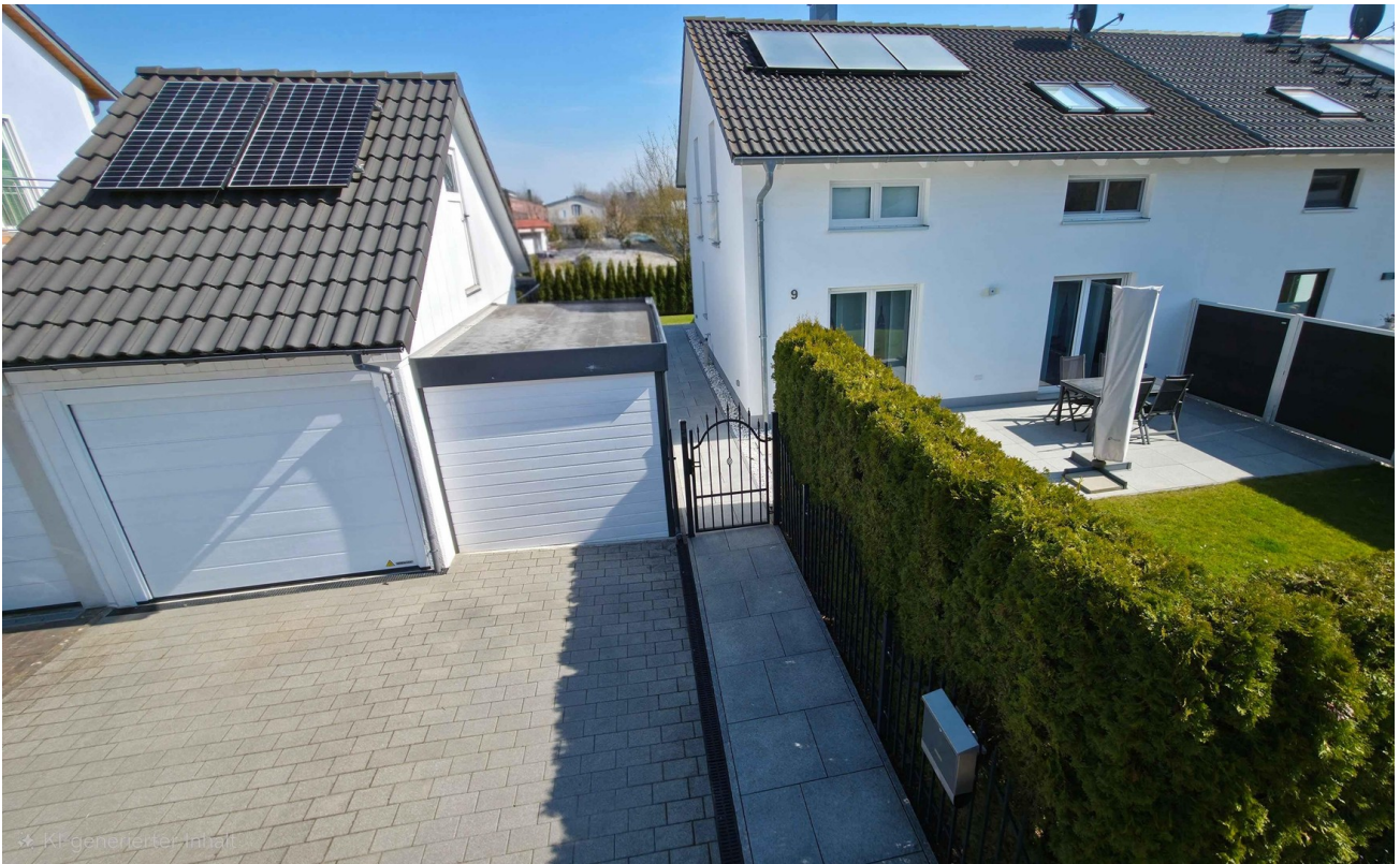
Süd-West Terrasse, Garage, HG
