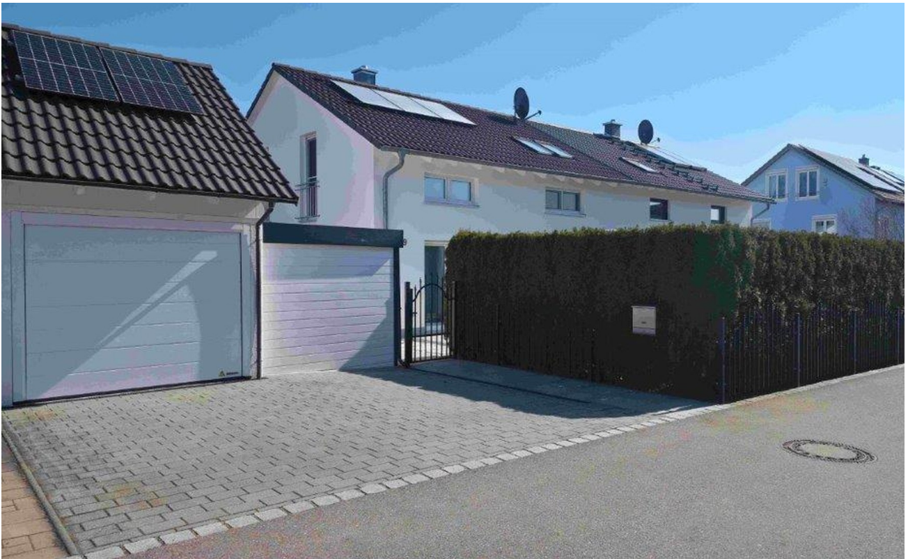
Ansicht von der Strasse
