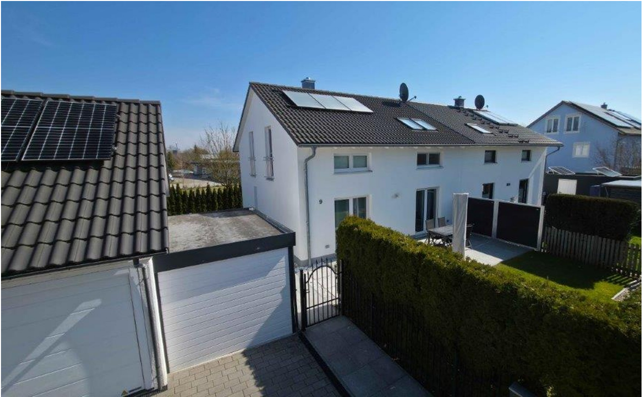
Ansicht von der Strasse
