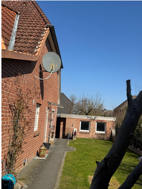
Der Garten zum Nebengebäude
