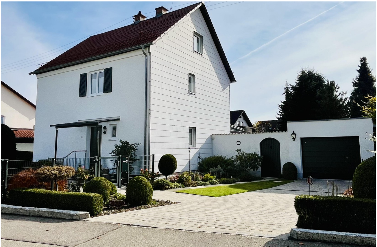
Einfahrt und Garage
