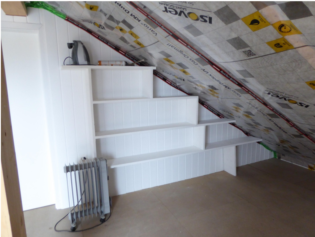
Gestell bleibt auf Dachboden
