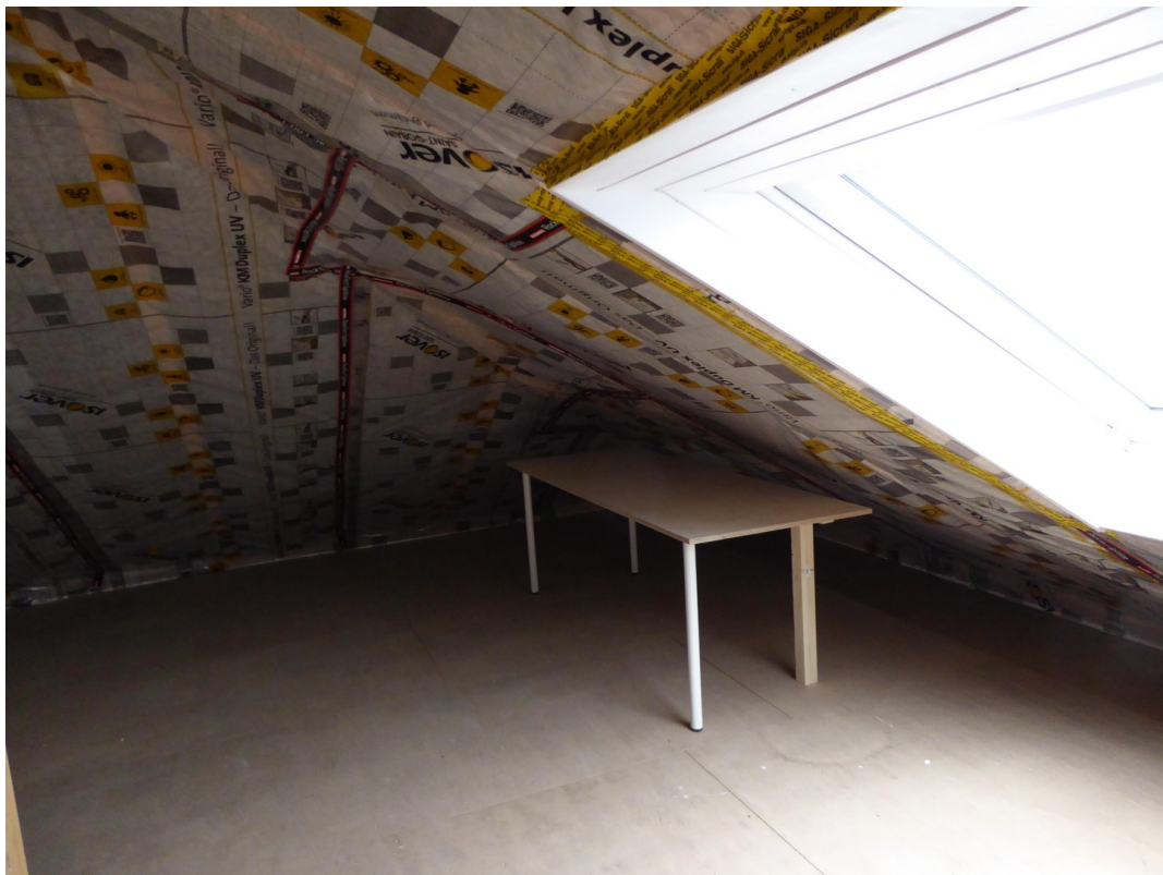
Dachboden nicht bei WF
