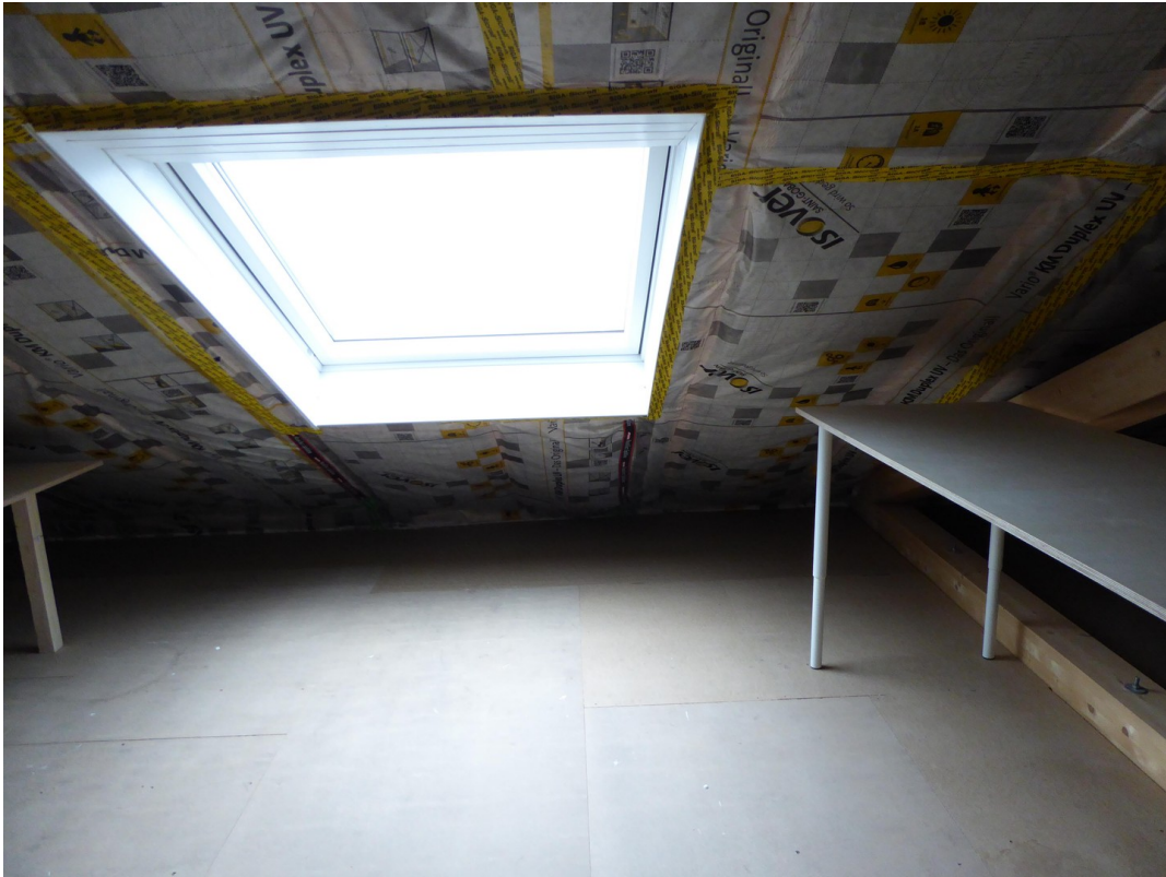
el. Fenster auf Dachboden
