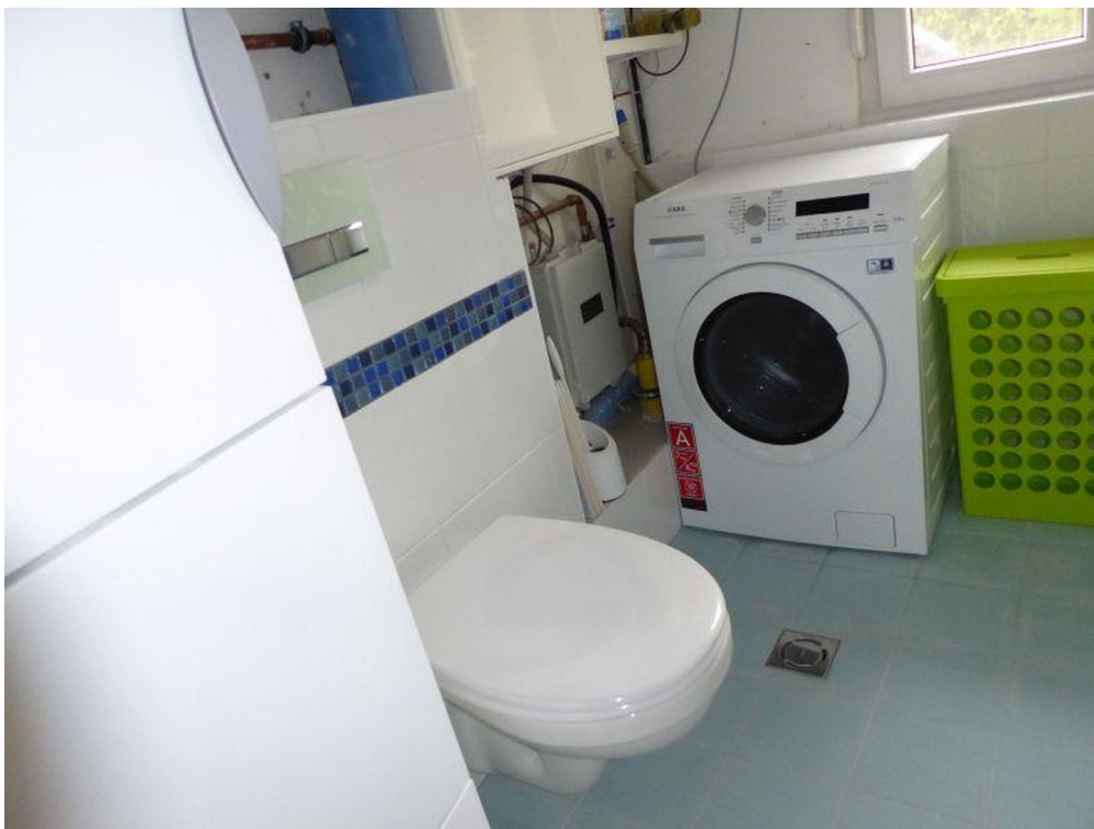
WC im Technikraum
