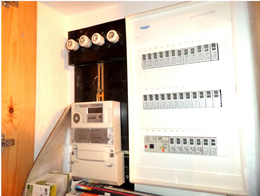
Sicherungskasten
