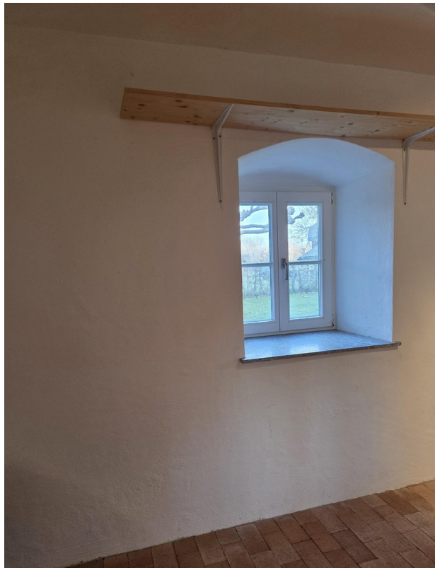
Keller mit 2 Tageslichtfenster
