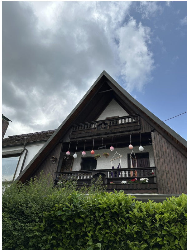
Außenblick auf den Balkon
