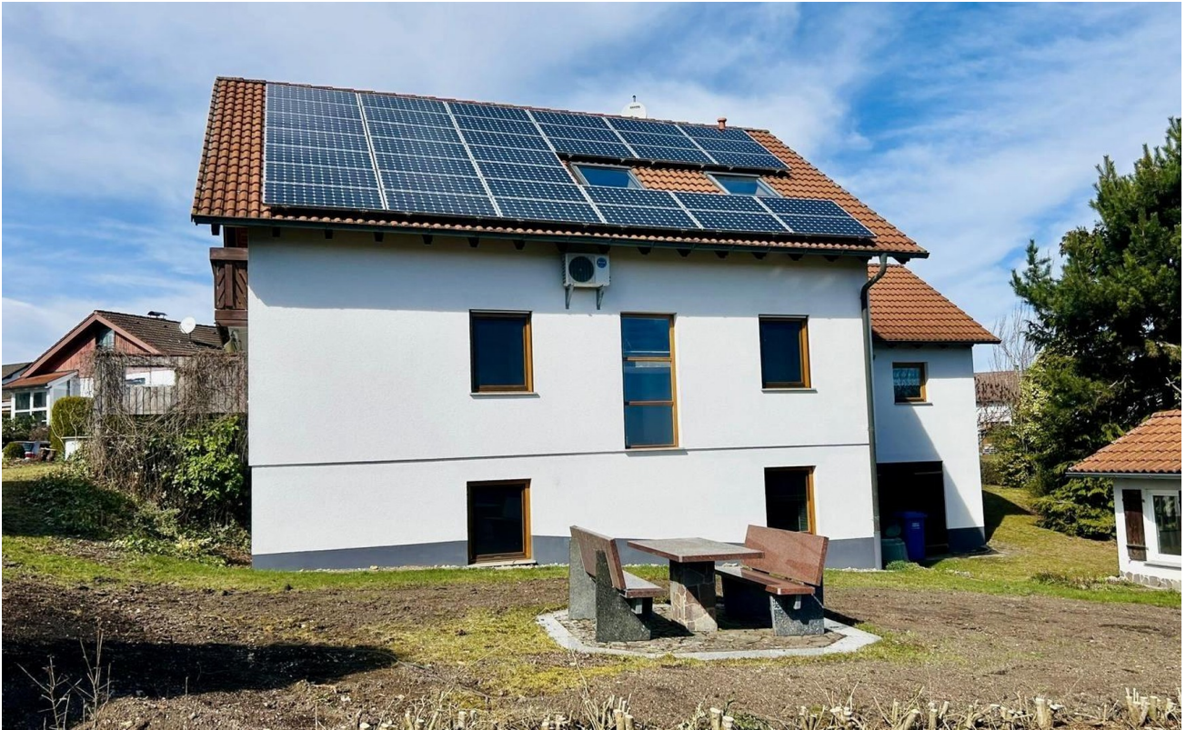
Südansicht mit PV-Anlage
