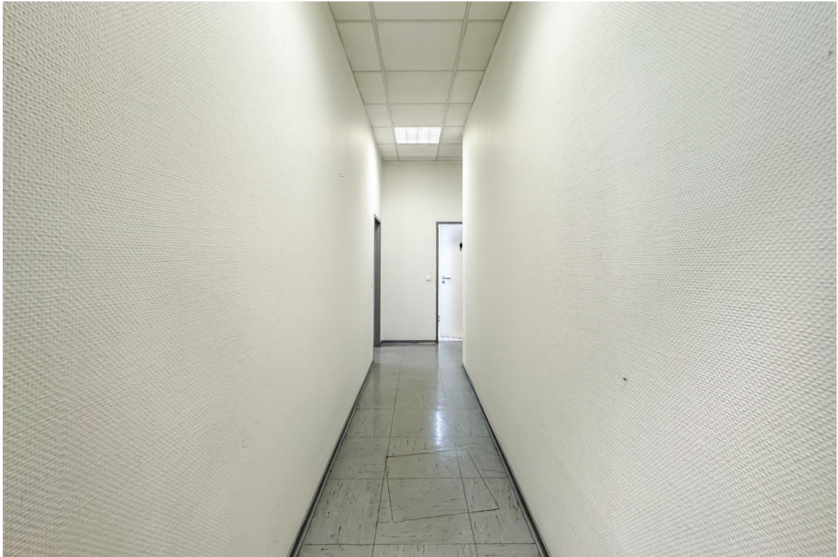
Flur zu Küche und WCs
