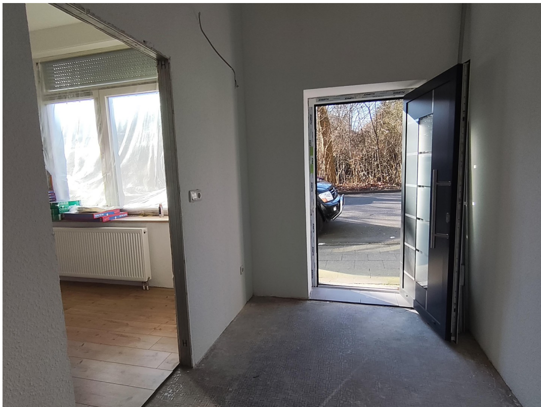
Eingang von Strasse
