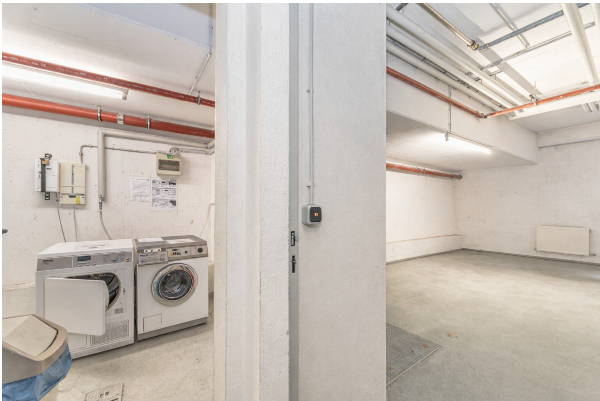
Waschküche im Keller
