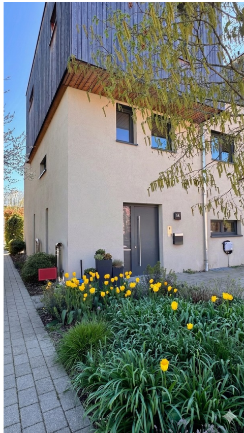
Haus Front und Vorgarten
