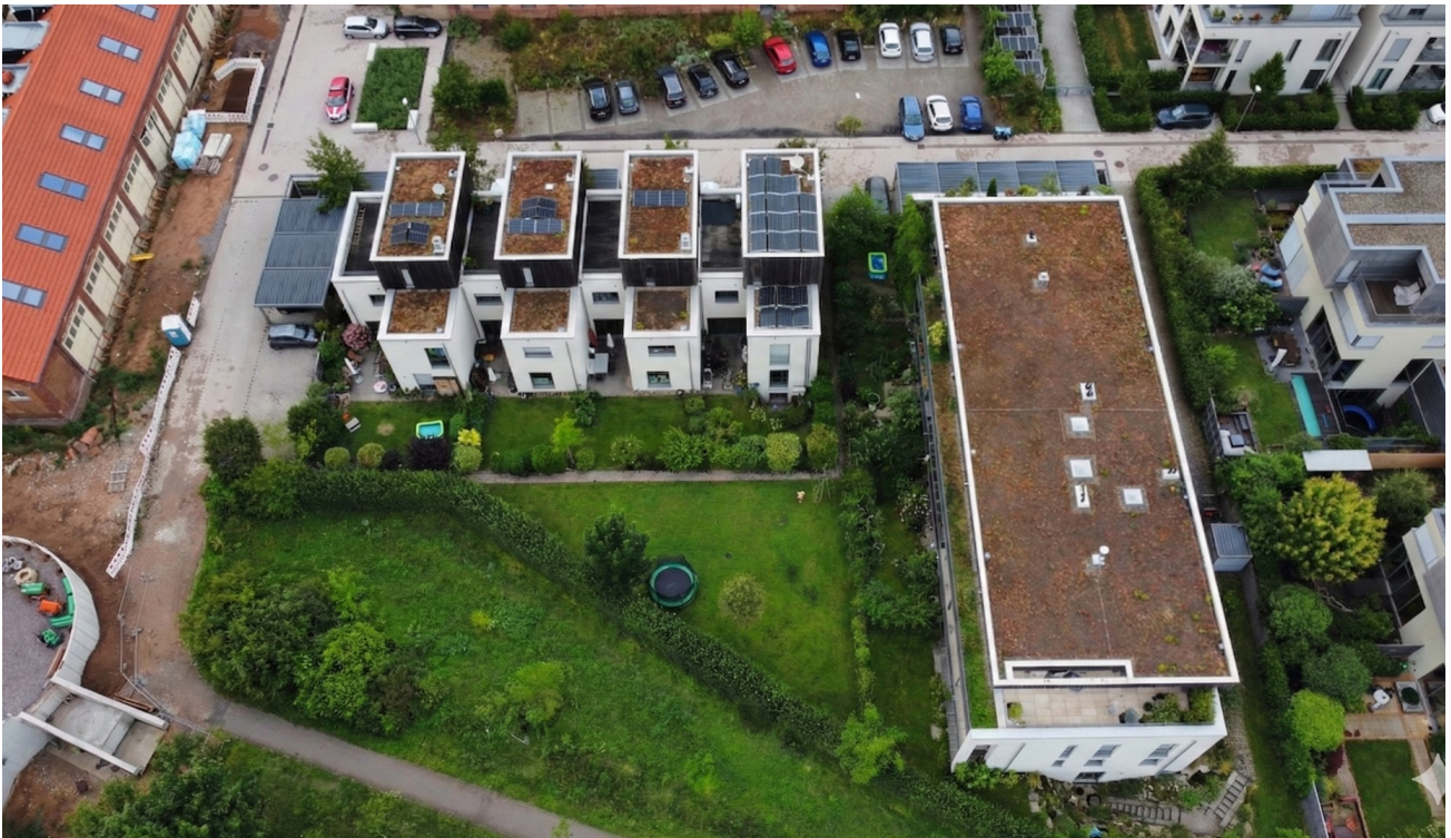
Gesamtgrundstück von oben
