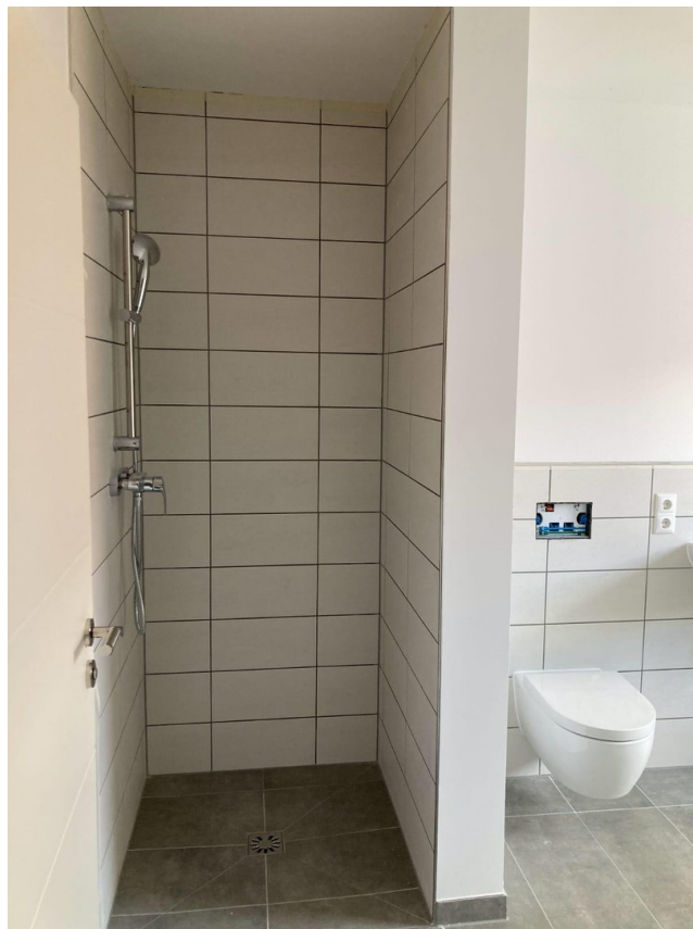
Badezimmer im OG
