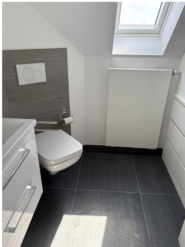
WC und Waschbecken Dachspitze
