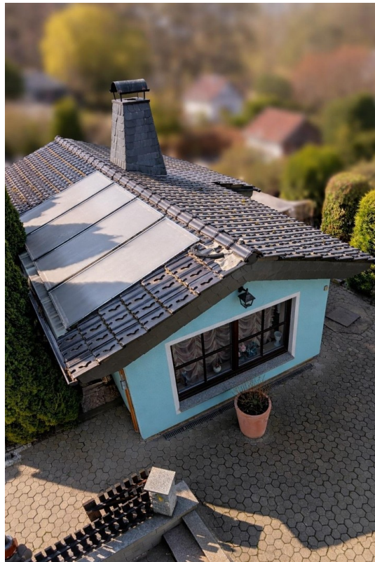
Blick von Balkon auf Hobbyraum
