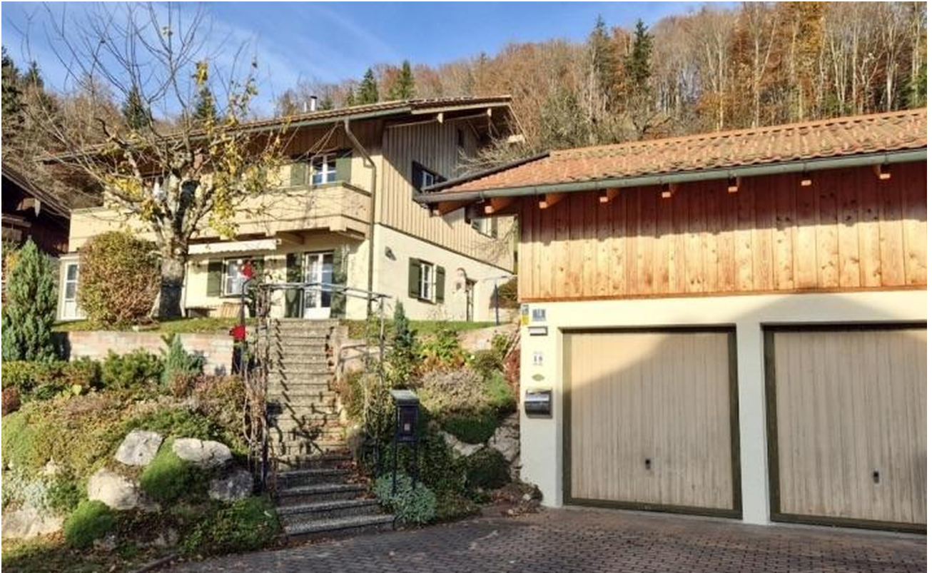
Doppelgarage mit Nebengebäude
