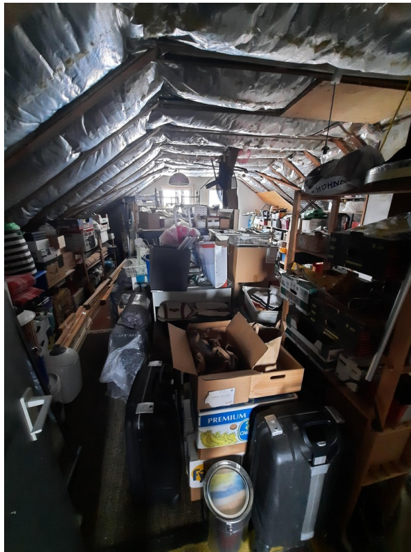
Dachgeschoss mit Ausbaureserve
