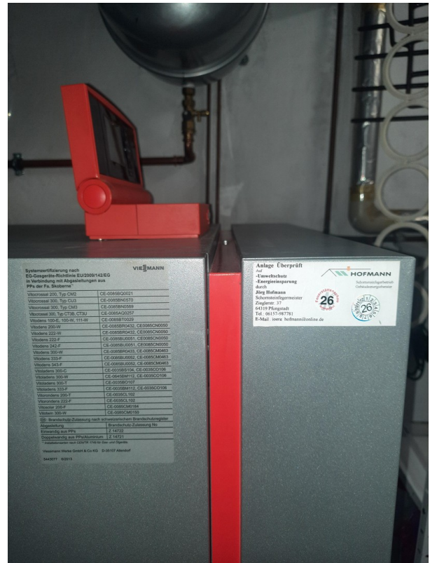
Öl Brennwertgerät Viessmann
