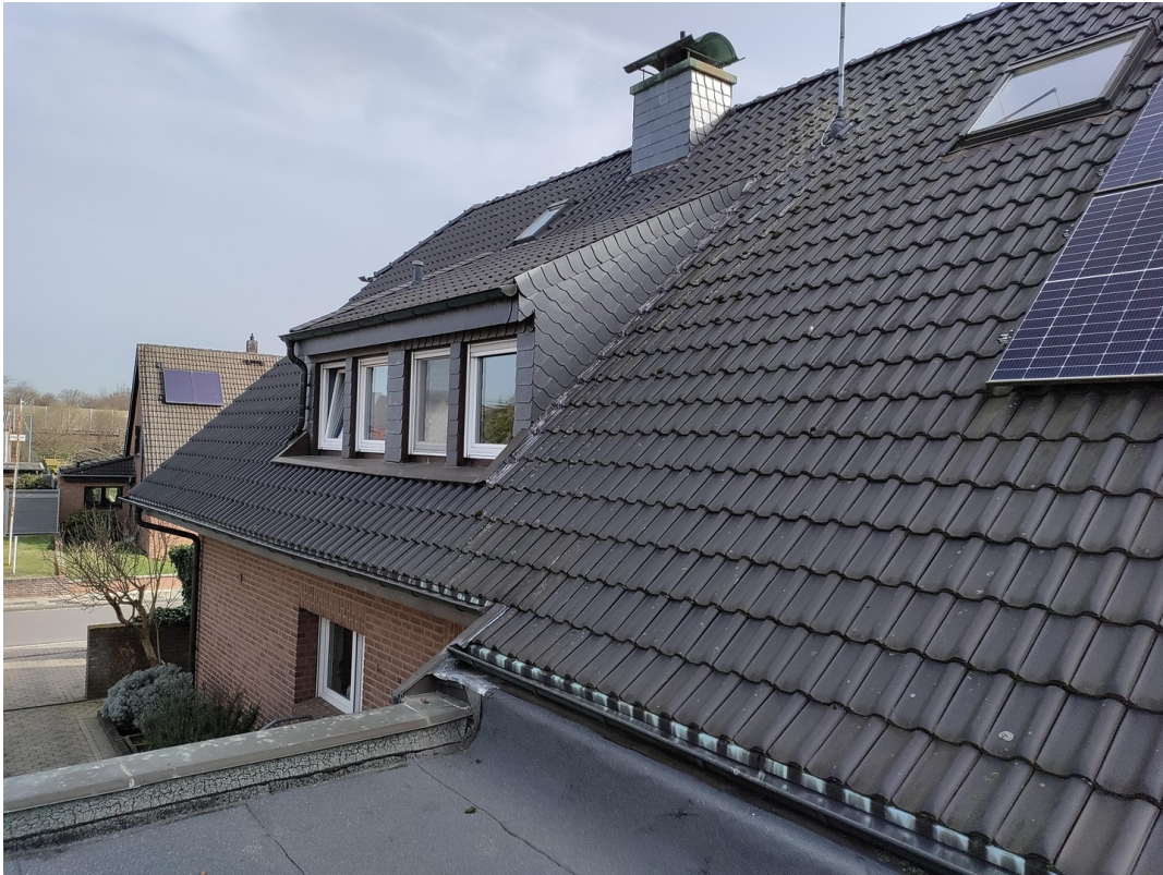
Dach mit Solaranlage
