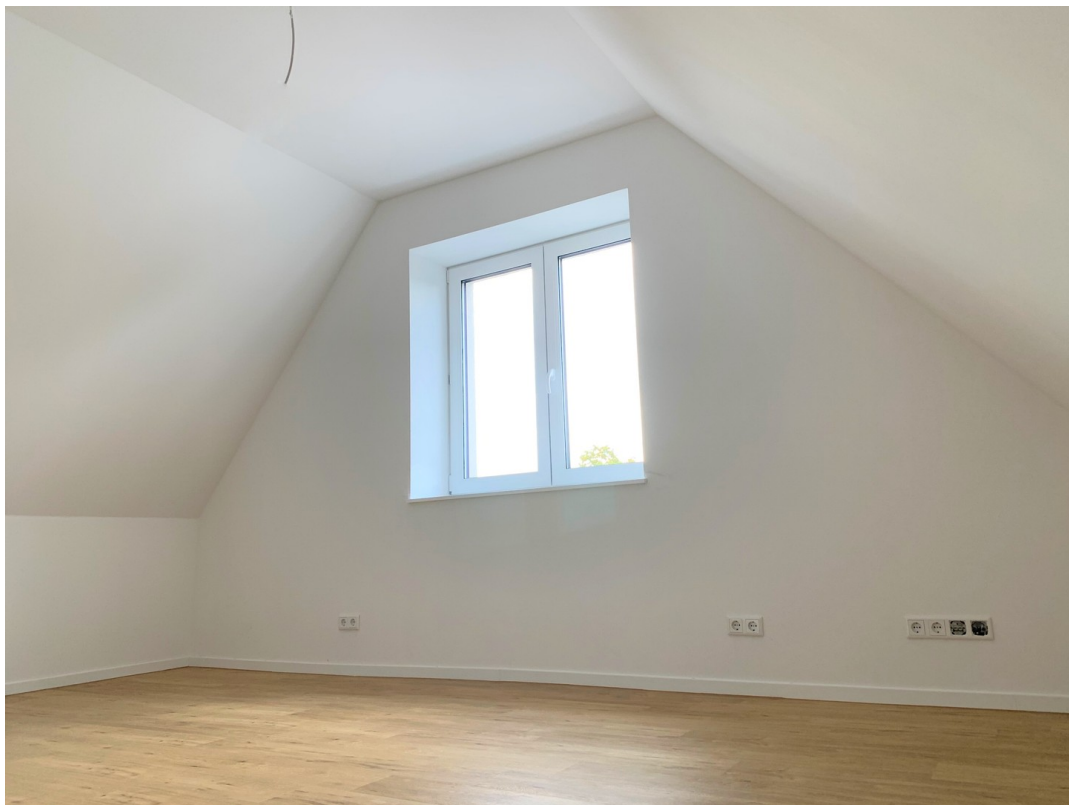
Raum in der zweiten Etage
