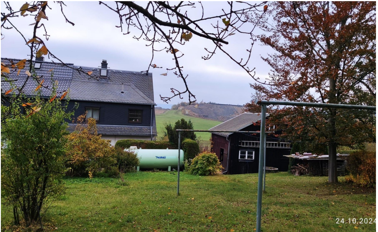
Außenansicht von Norden
