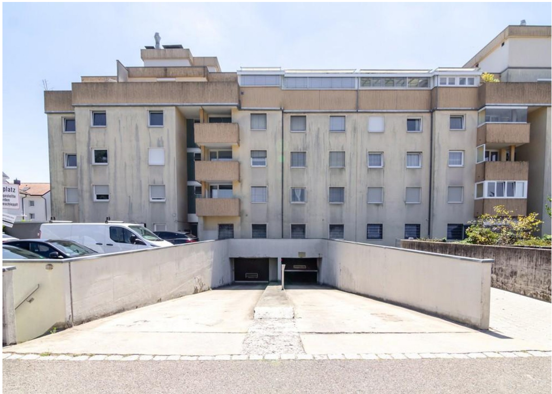
Einfahrt in die Tiefgarage
