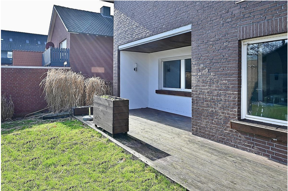
Blick von Garten auf Terrasse
