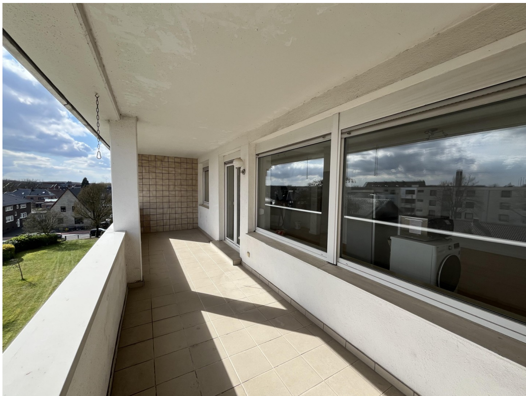
Überdachte großflächige Loggia
