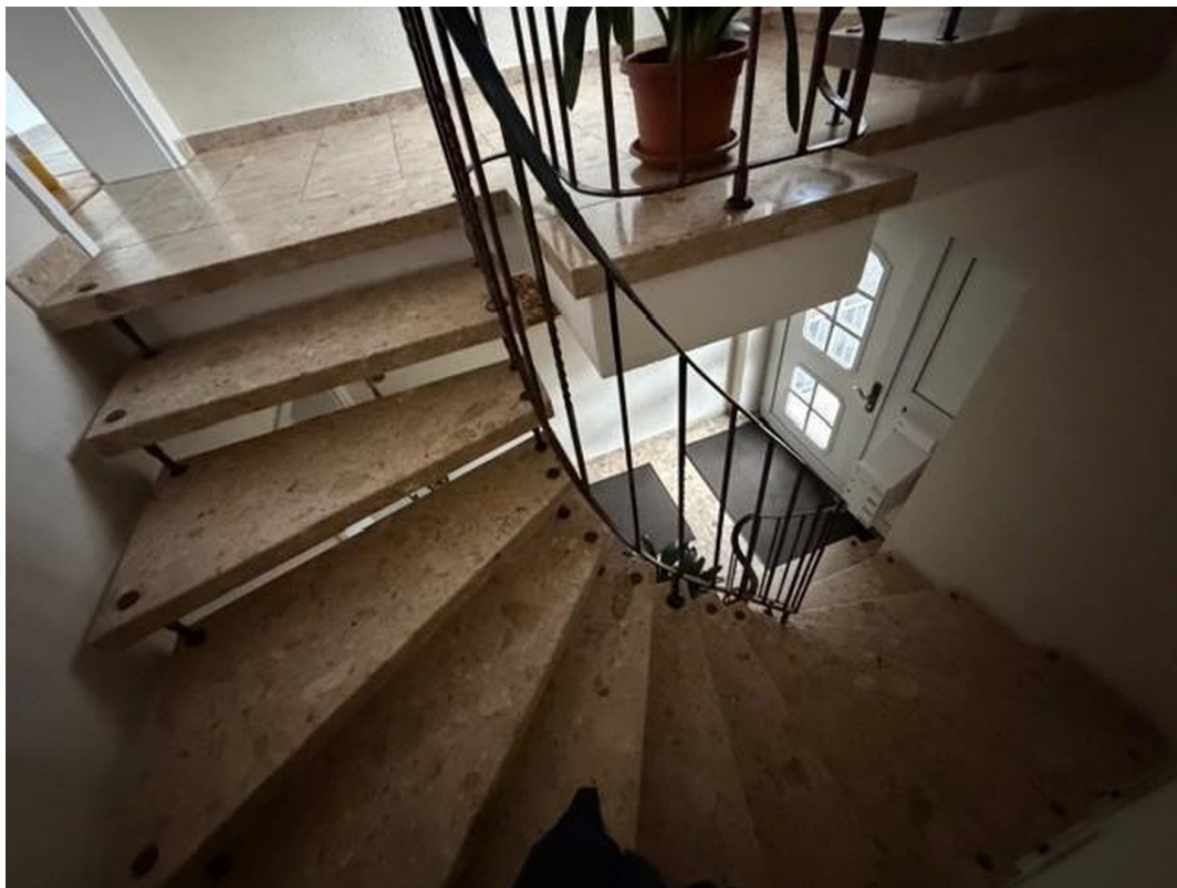
Treppe zum 1. OG
