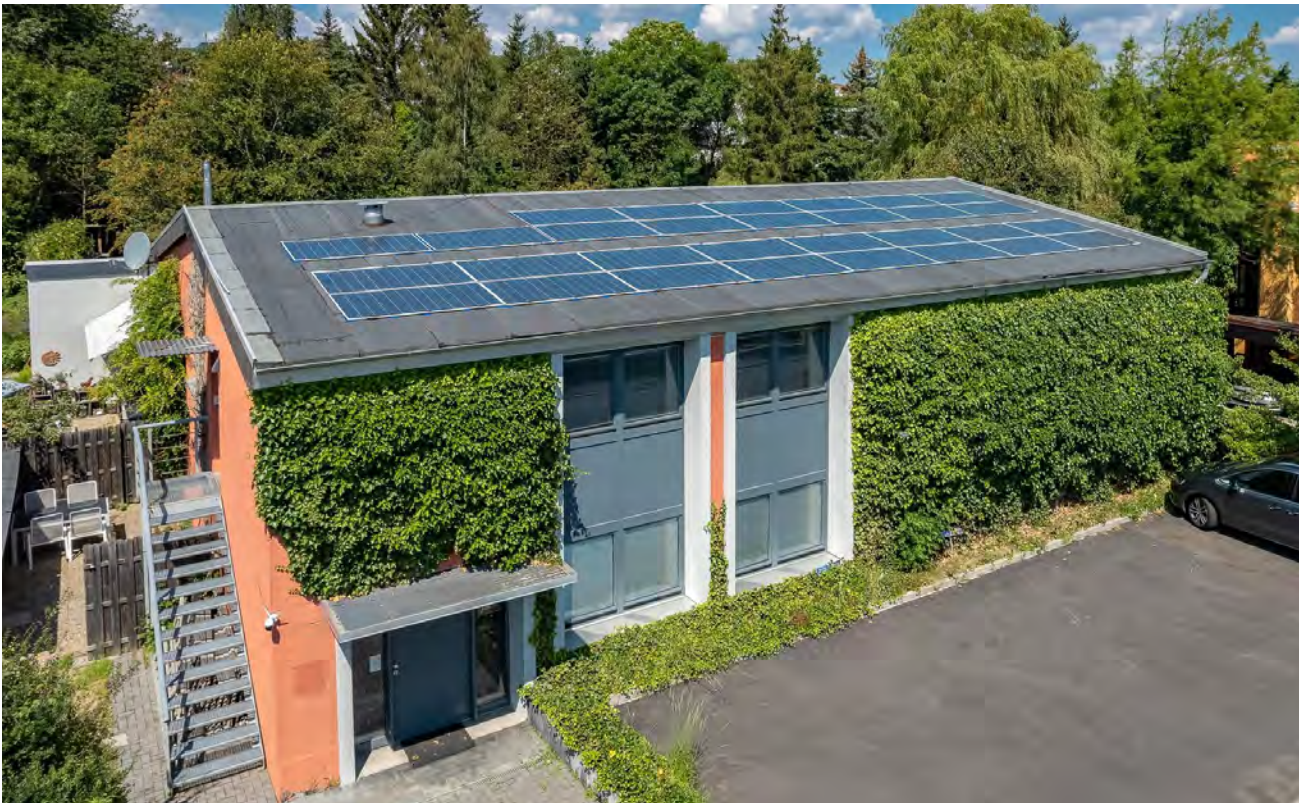
Ostseite, Außentreppe zum OG
