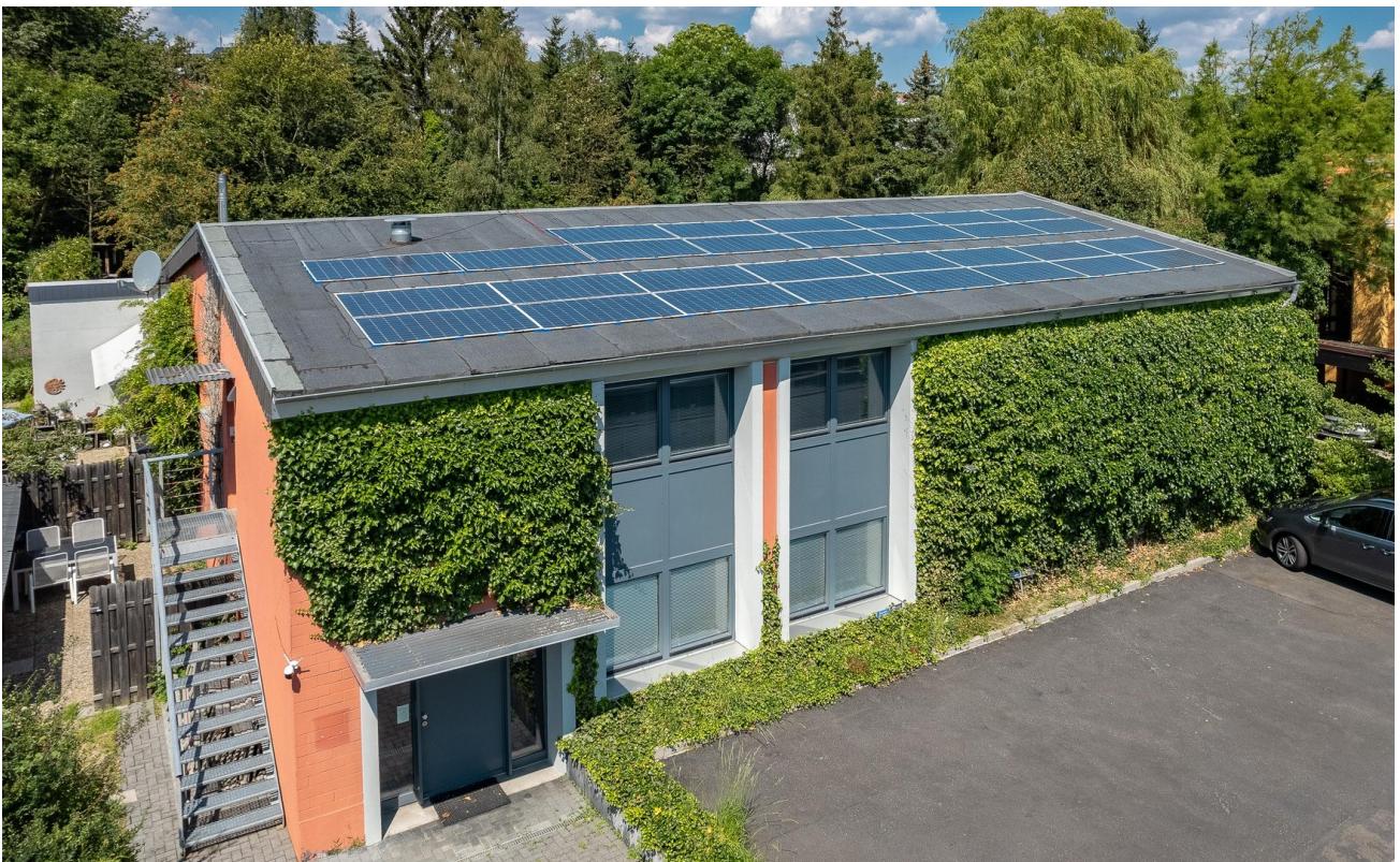
5 Parkplätze vor dem Gebäude
