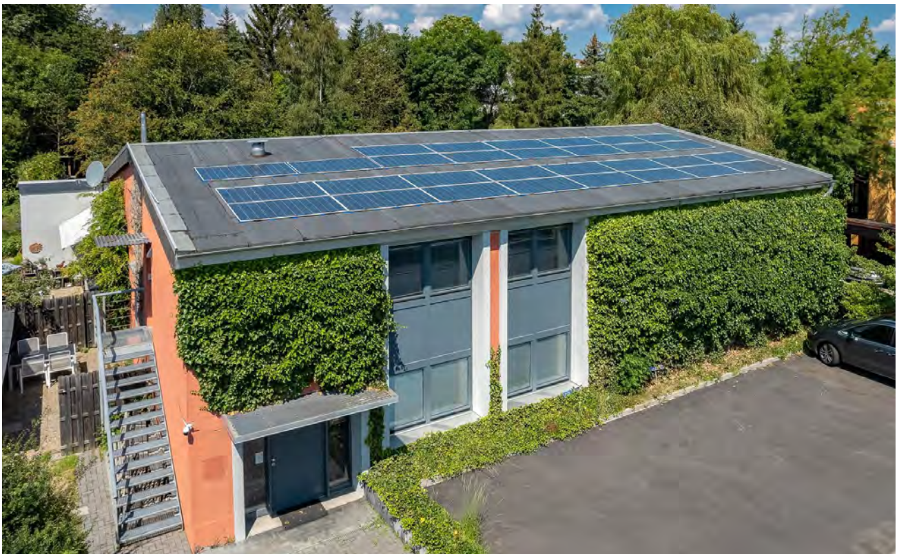
Ostseite, Außentreppe zum OG
