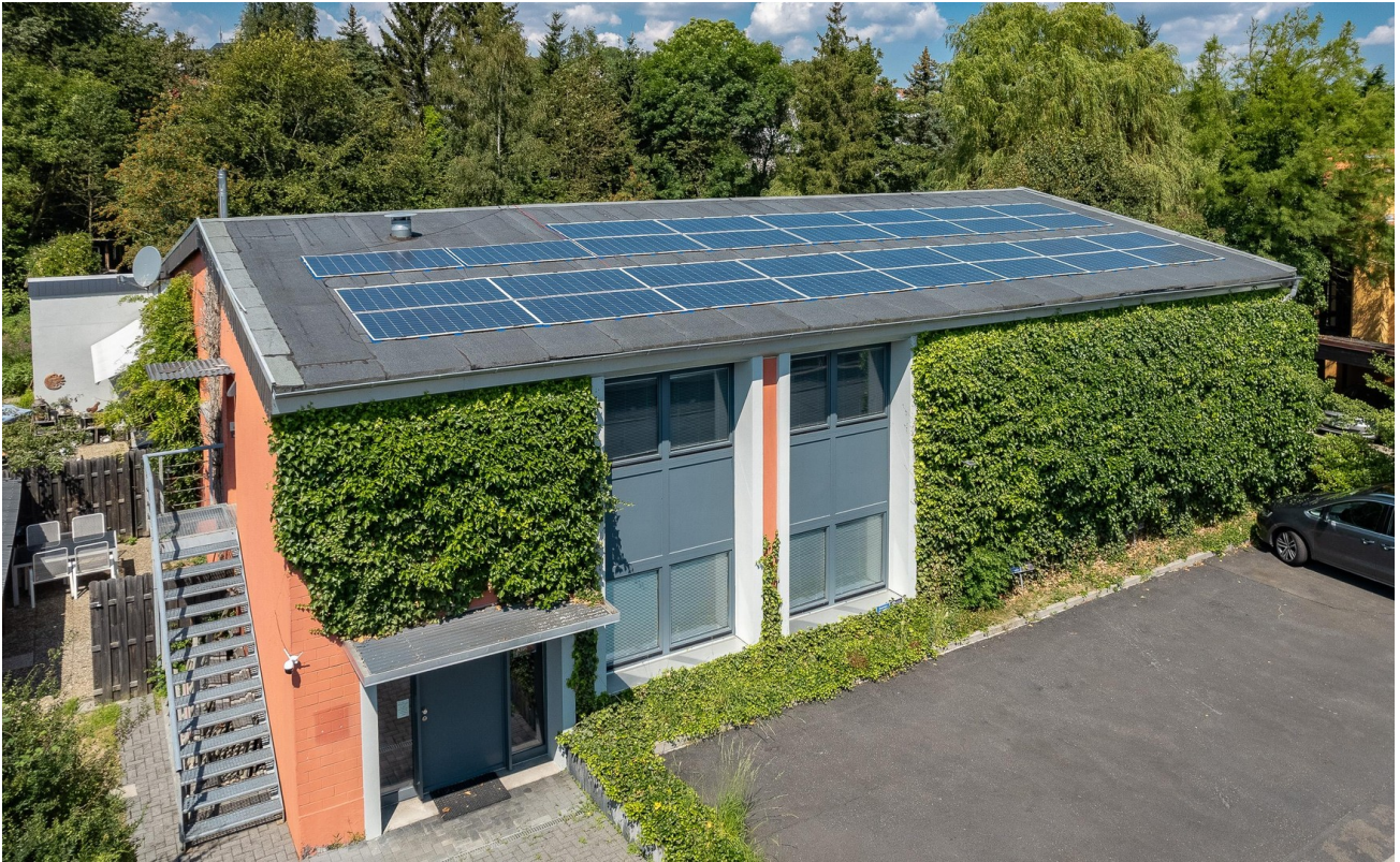
5 Parkplätze vor dem Gebäude
