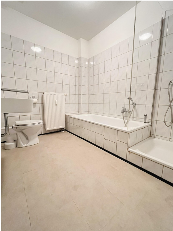
Bad mit neuem Vinylboden
