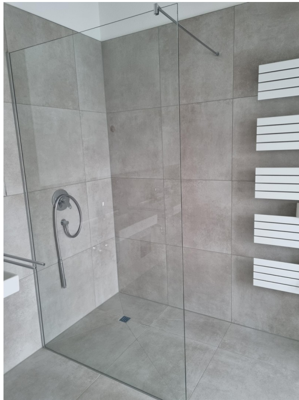
ebene Dusche m. Handtuchheizk.
