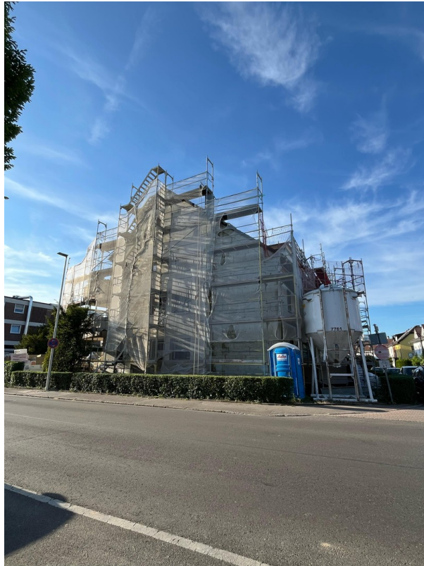
Fassade zur Sanierung
