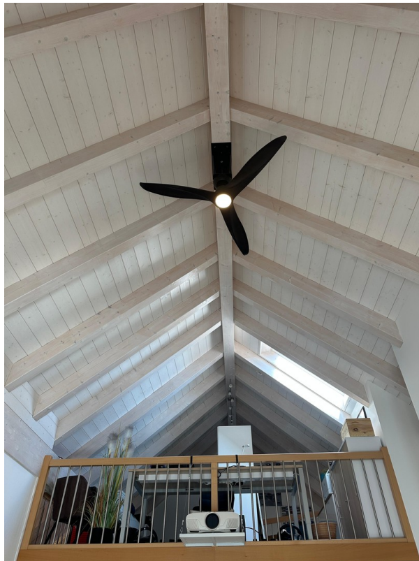
Lüfter mit Licht
