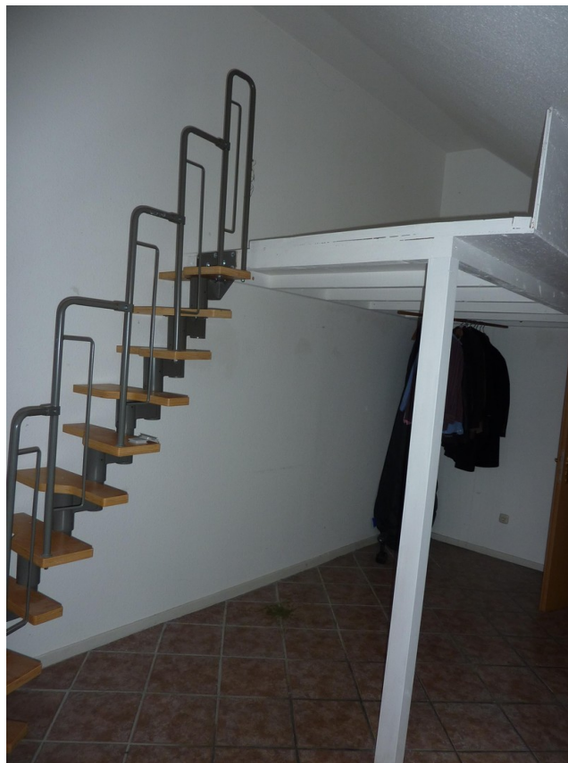
Zugang Schafebene DG-Whg
