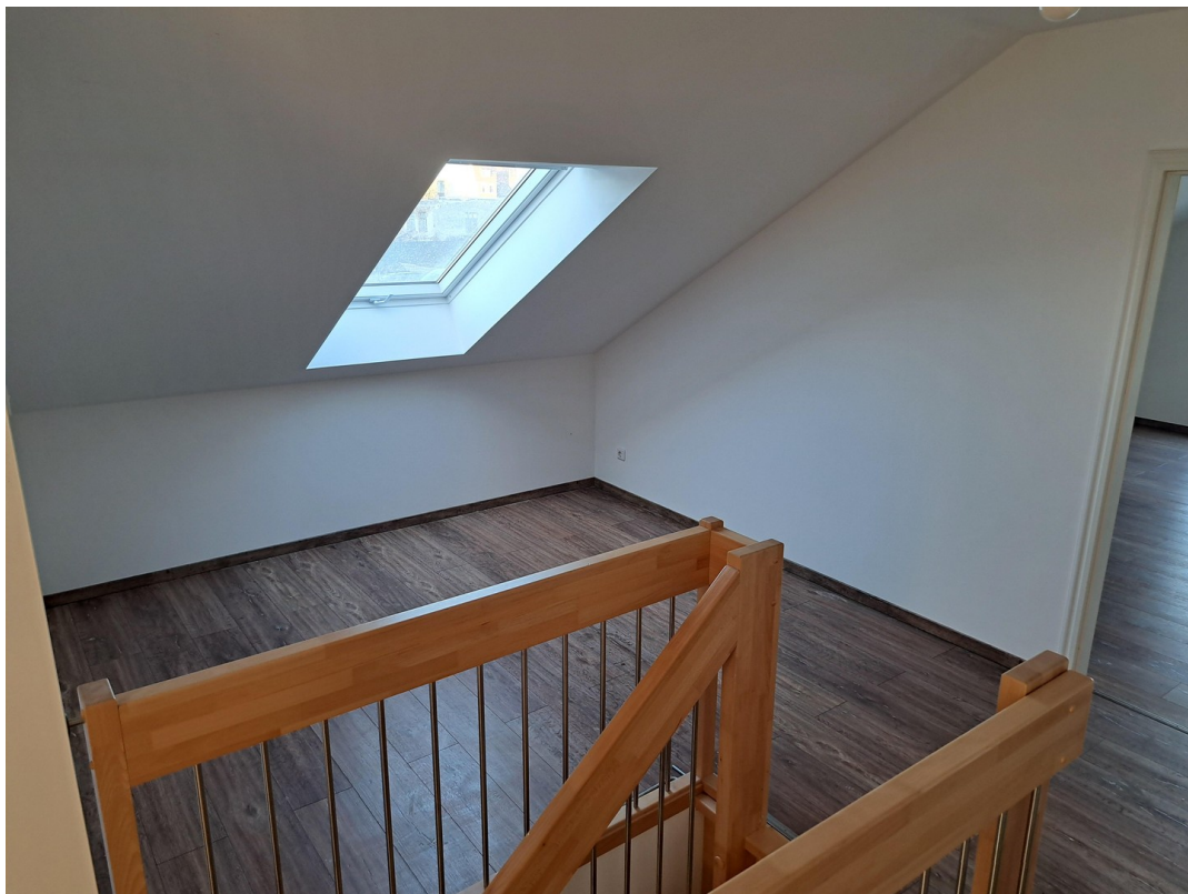
Galerie im Dachgeschoss
