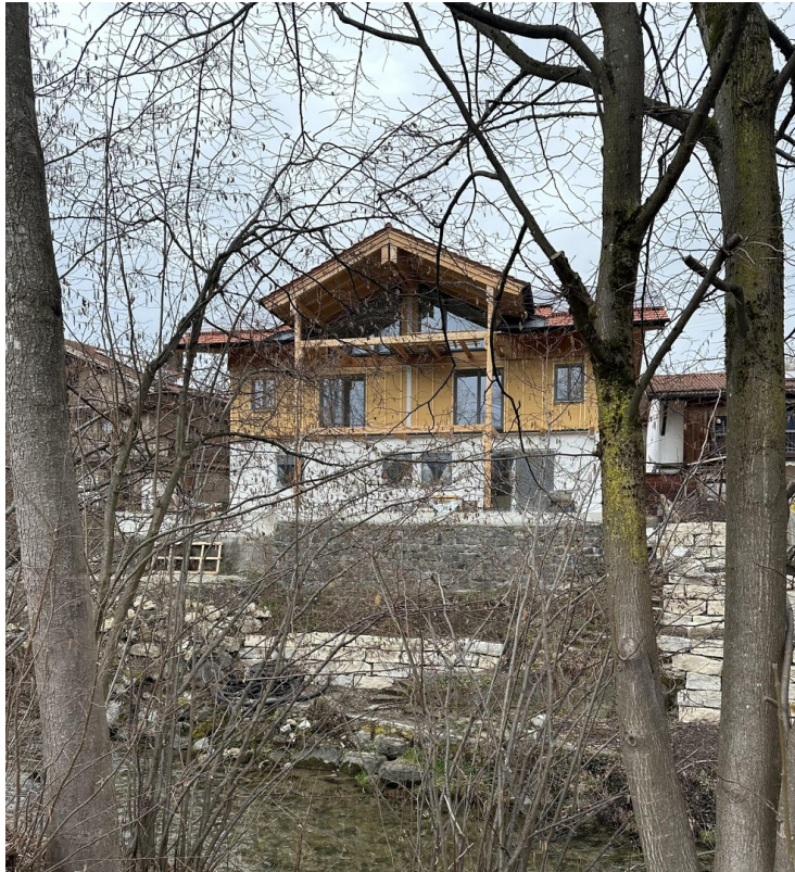
Balkone auf der Südseite
