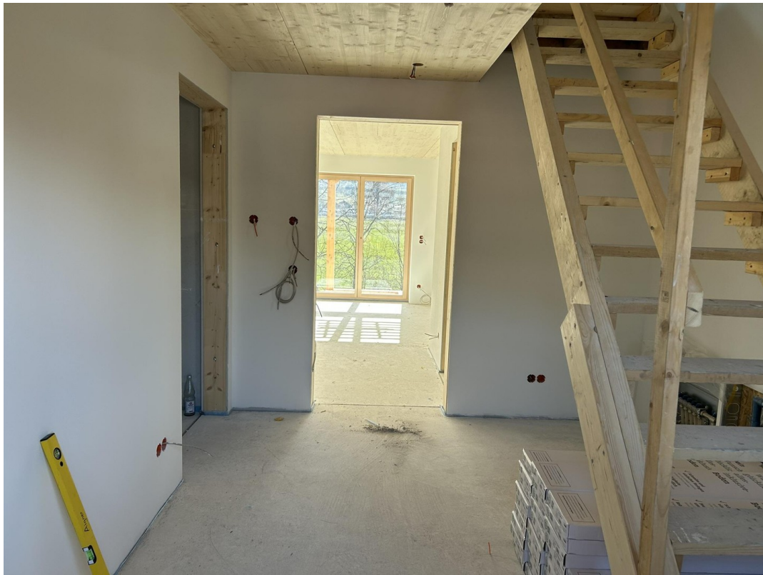
Blick von der Eingangstüre
