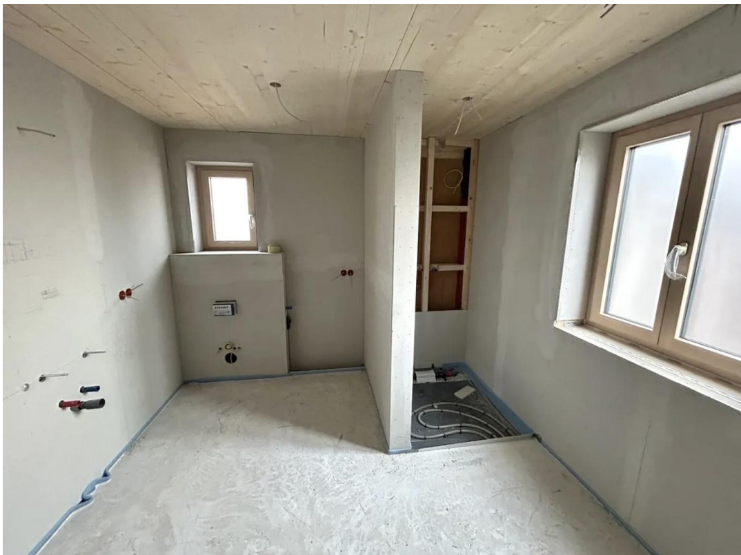
Bad im OG (rechts die Dusche)
