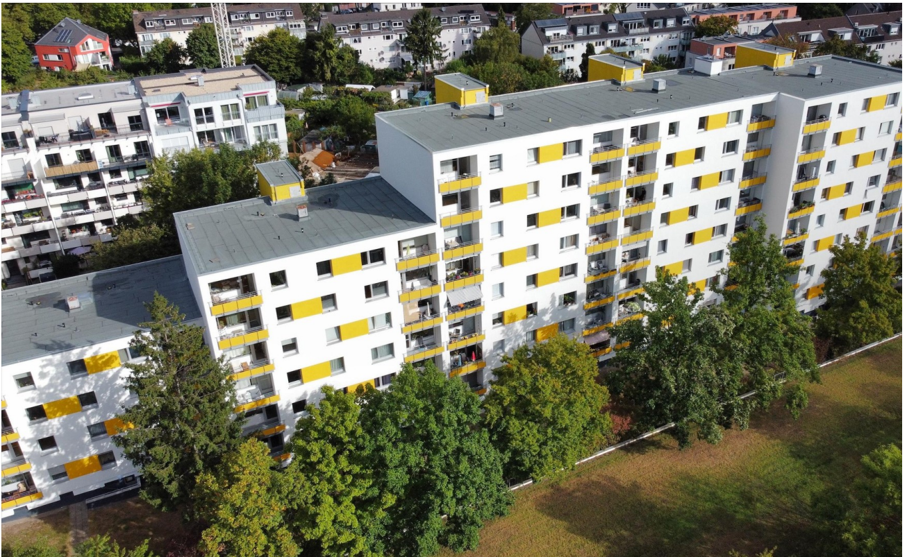
Objekt nach Sanierung 2025
