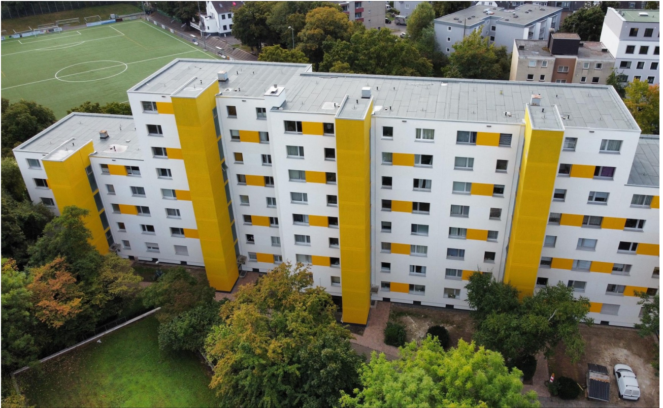
Objekt nach Sanierung 2025
