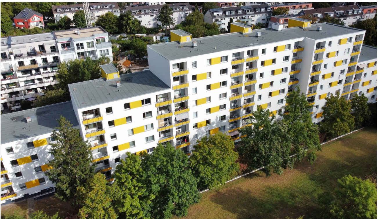
Objekt nach Sanierung 2025
